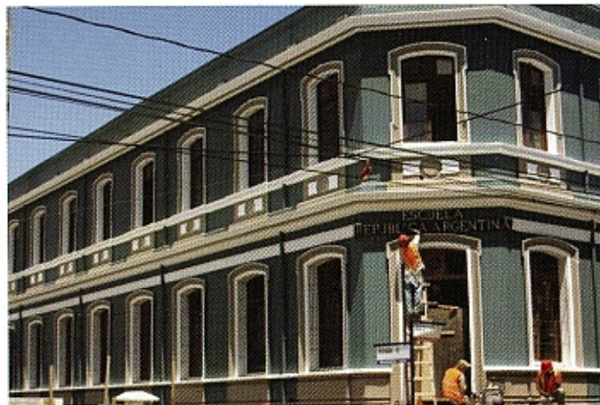
Obras de Restauración de Antigua Escuela República de Argentina, Heredia centro, 2010
